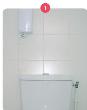
• sortie flexible pour cuvette wc rattachement direct à la chasse d'eau.
